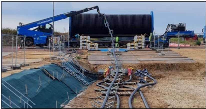
Viel Technik und wenig Menschenhand begleiten den Einzug des SuedLink-Kabels in die Allerquerung. Foto: Precht
